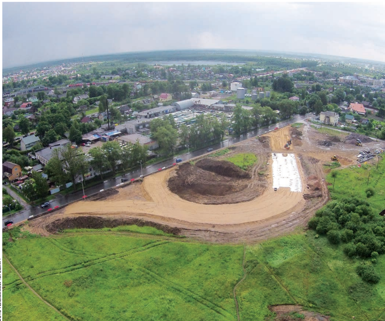
Вид сверху на место строительства разворотного кольца.
